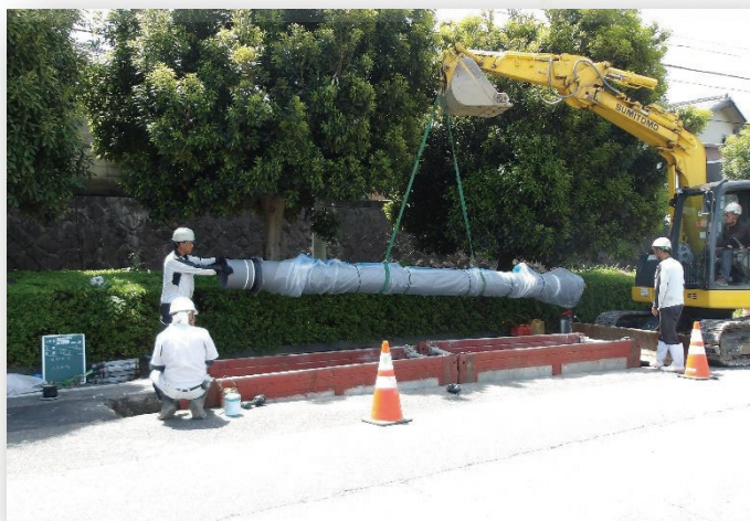
【配水本管布設替工事】
